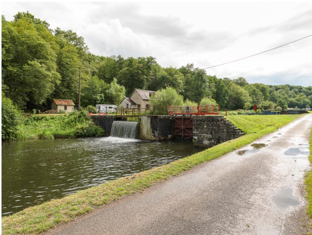
Vue du déversoir de superficie.
