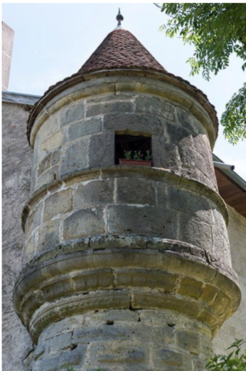
Détail de l'échauguette de l'ancienne écurie
