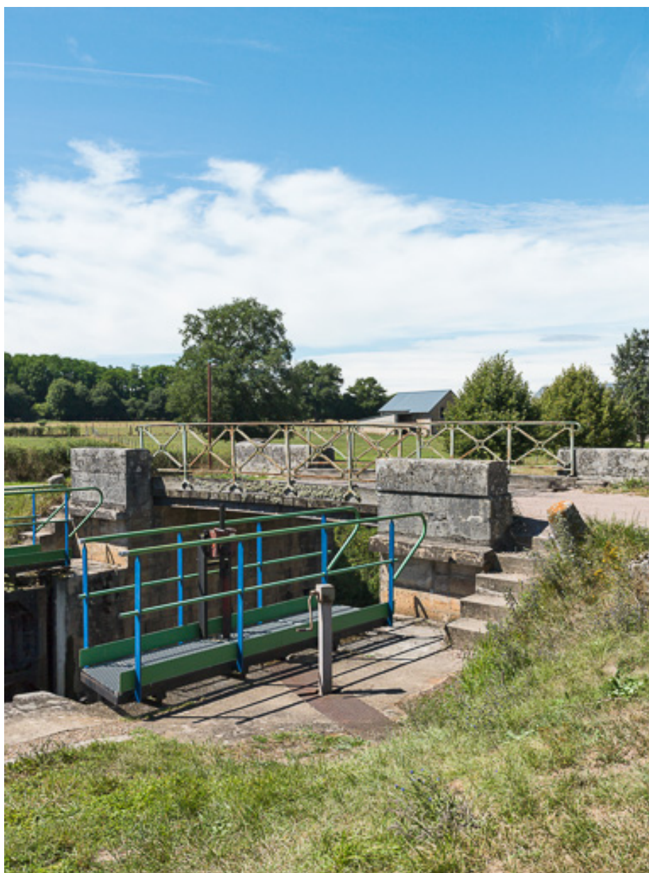
Vue rapprochée du pont et des escaliers.
