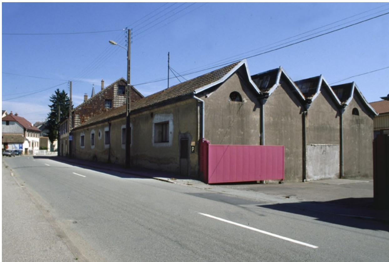
Atelier de fabrication longeant la rue d'Etueffont.
