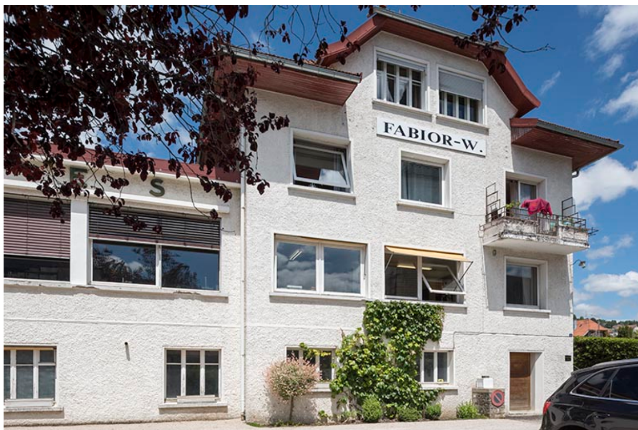
Façade antérieure de la maison.
