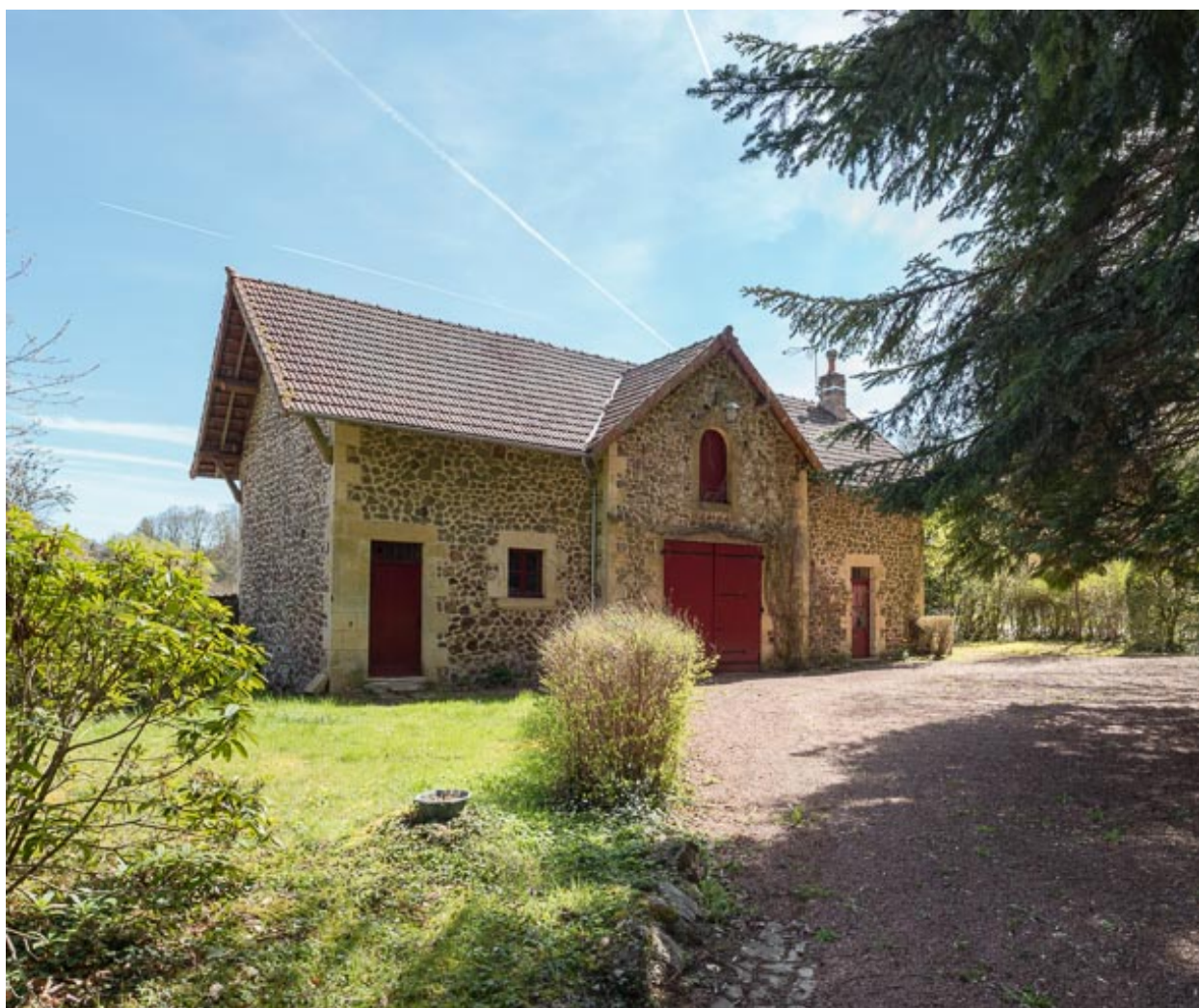
Façade principale donnant sur la villa.
