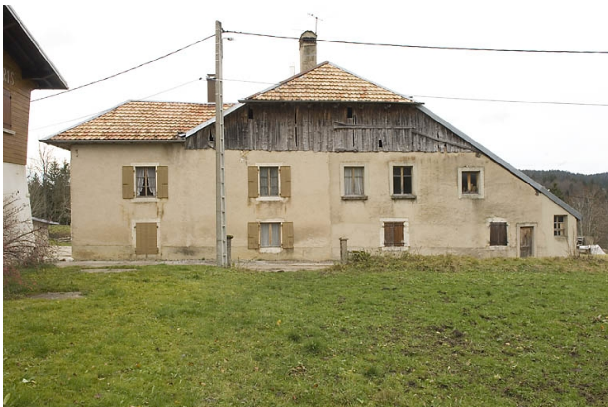
Façade latérale droite.
