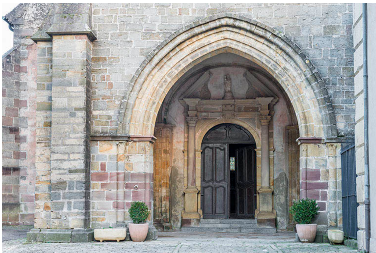
Vue rapprochée du porche.
