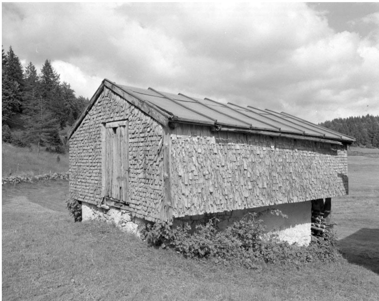
L'accès à l'étage de la resserre.
