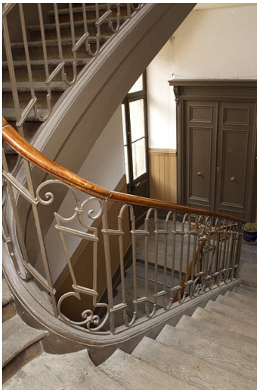
Vue de l'intérieur de l'escalier.
