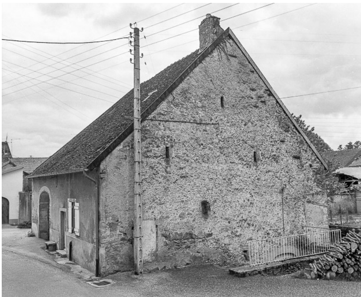
Façades antérieure et latérale droite.
