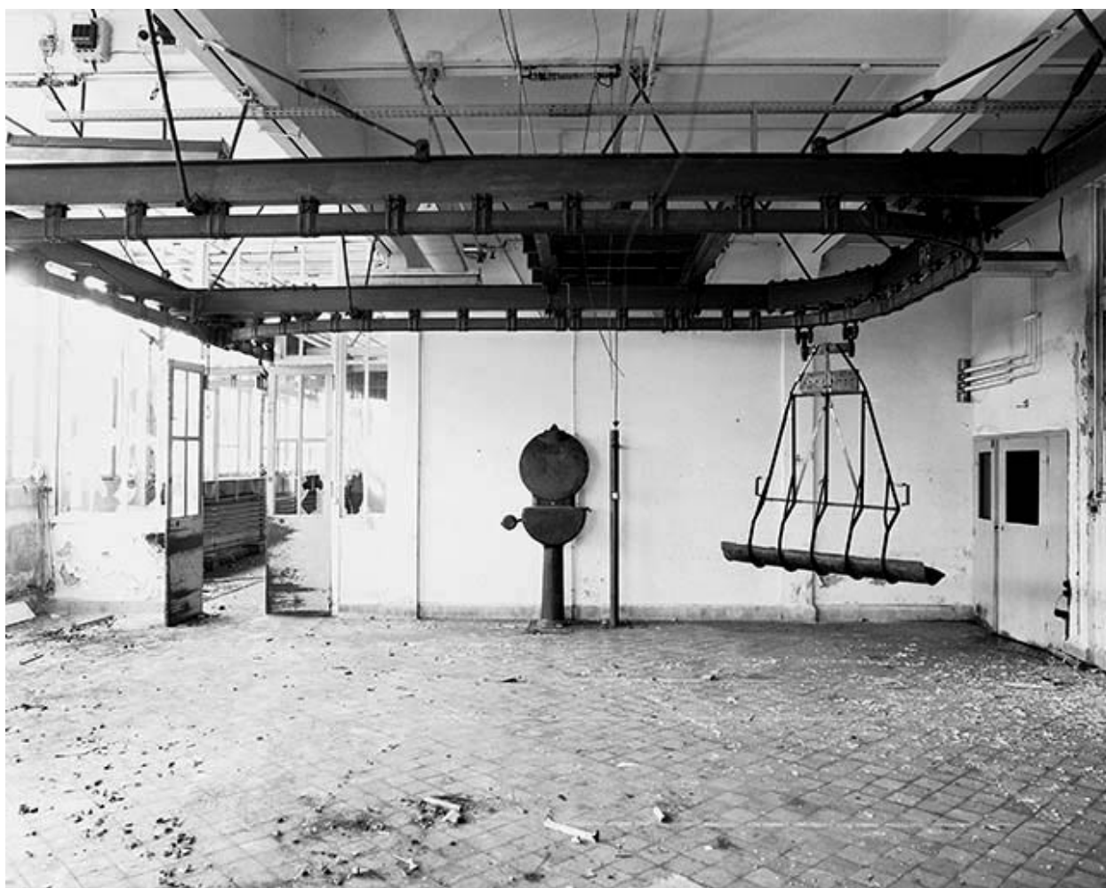
Bascule du monorail et chariot suspendu.
