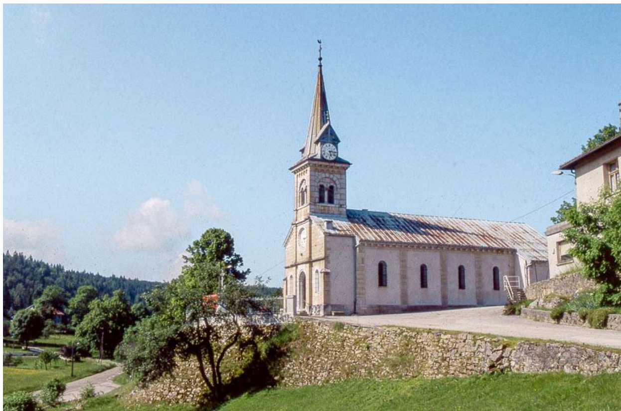
Façade antérieure et face droite.
