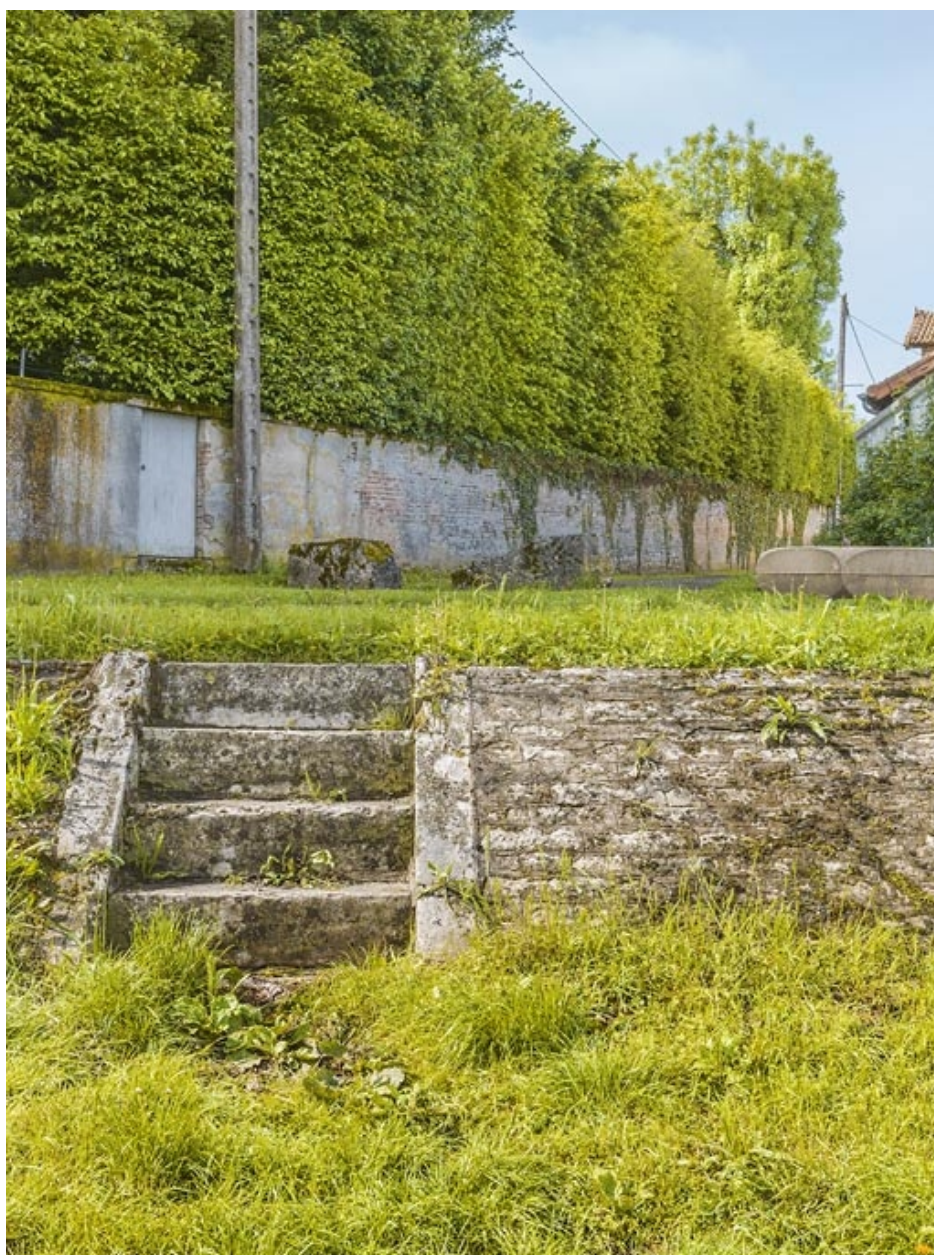
Deuxième escalier de la digue.
