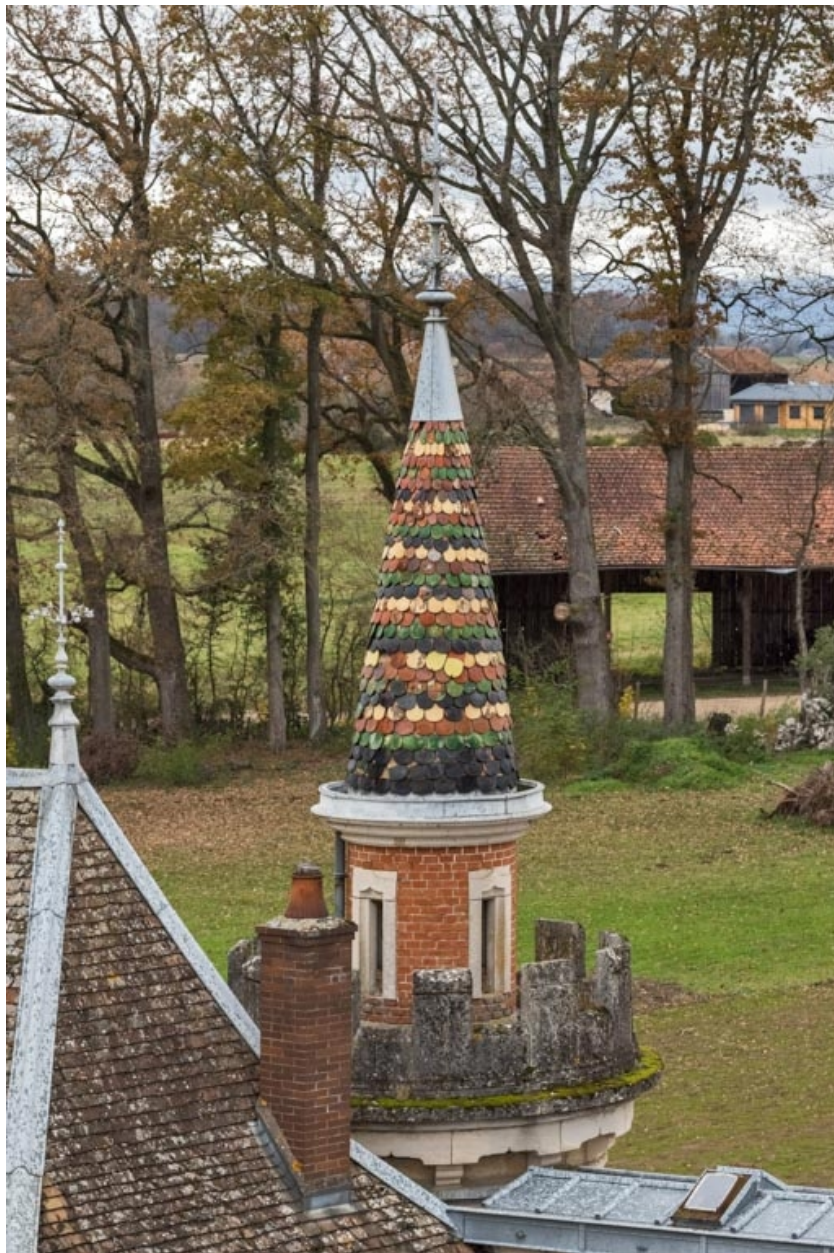
Galerie : tourelle ouest, depuis le "Donjon".
