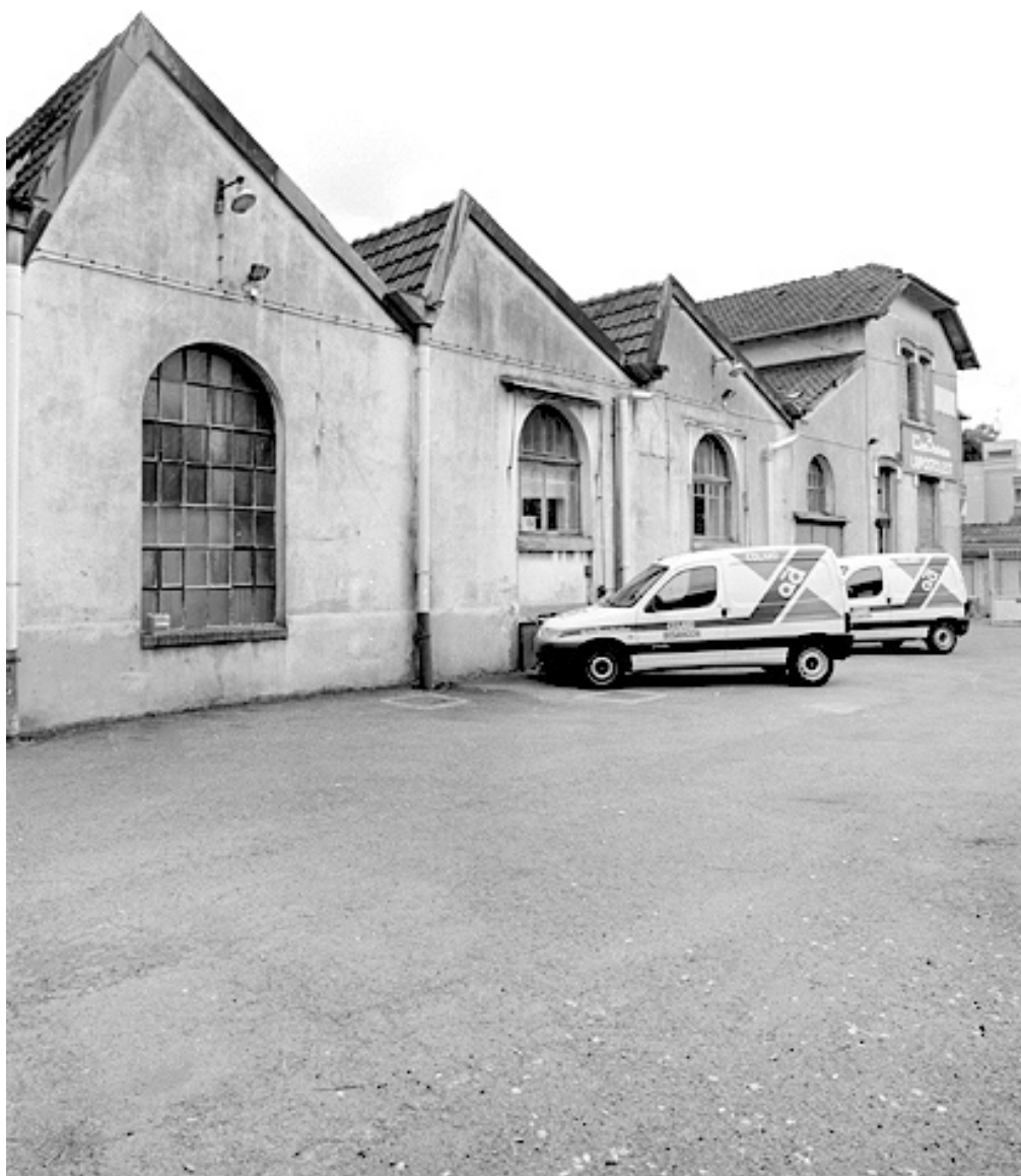
Murs-pignons ouest des ateliers depuis la cour.
