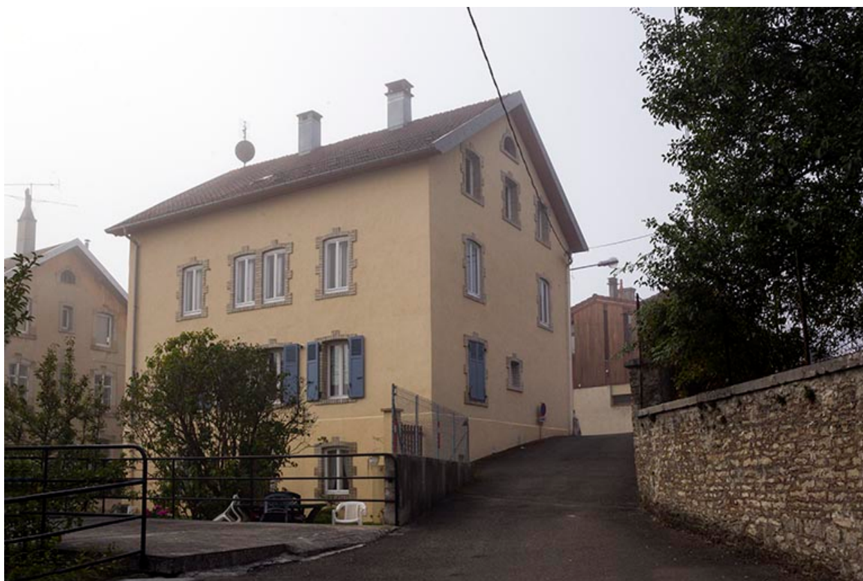
Façades postérieure et latérale gauche.
