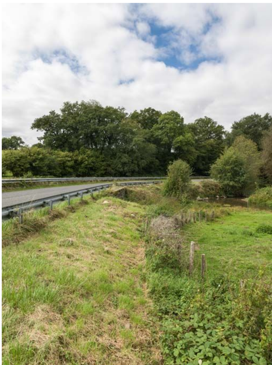
Vue de l'aqueduc.
