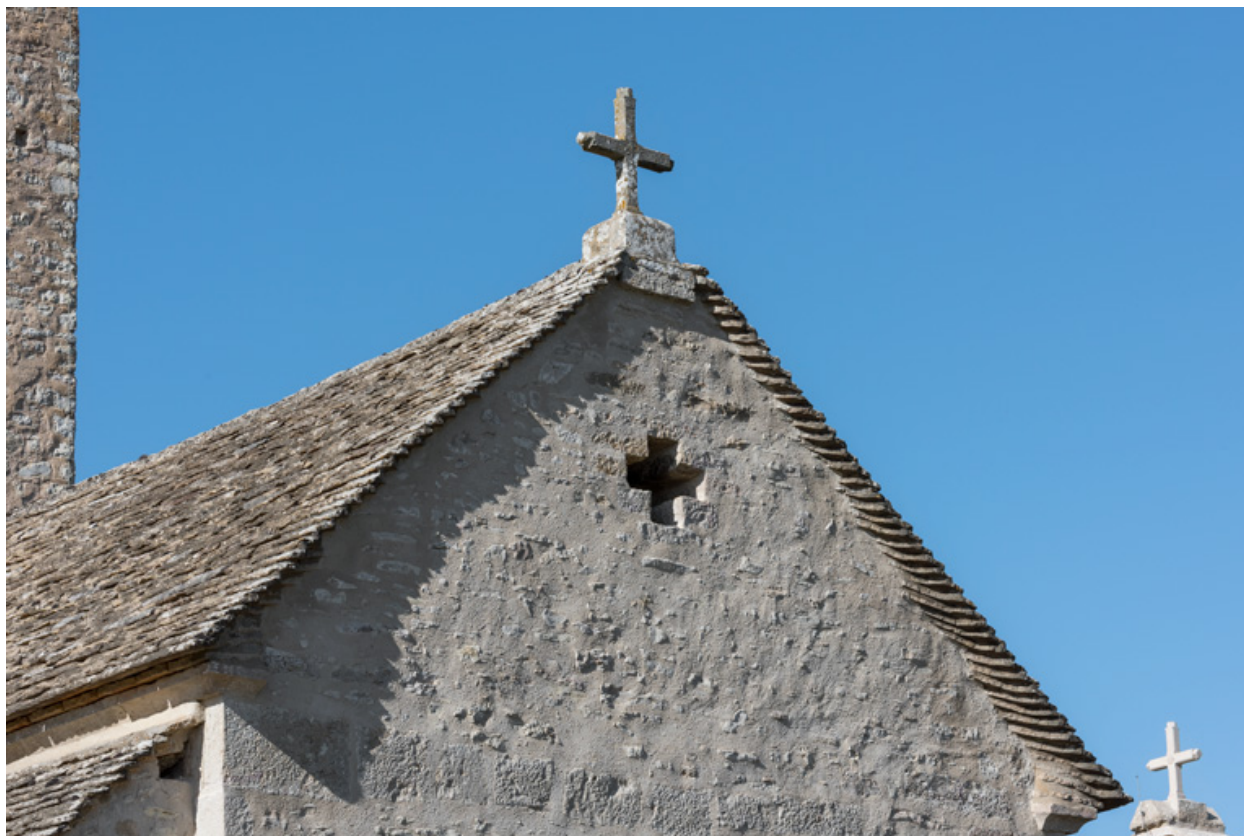
Pignon couvert de la façade.
