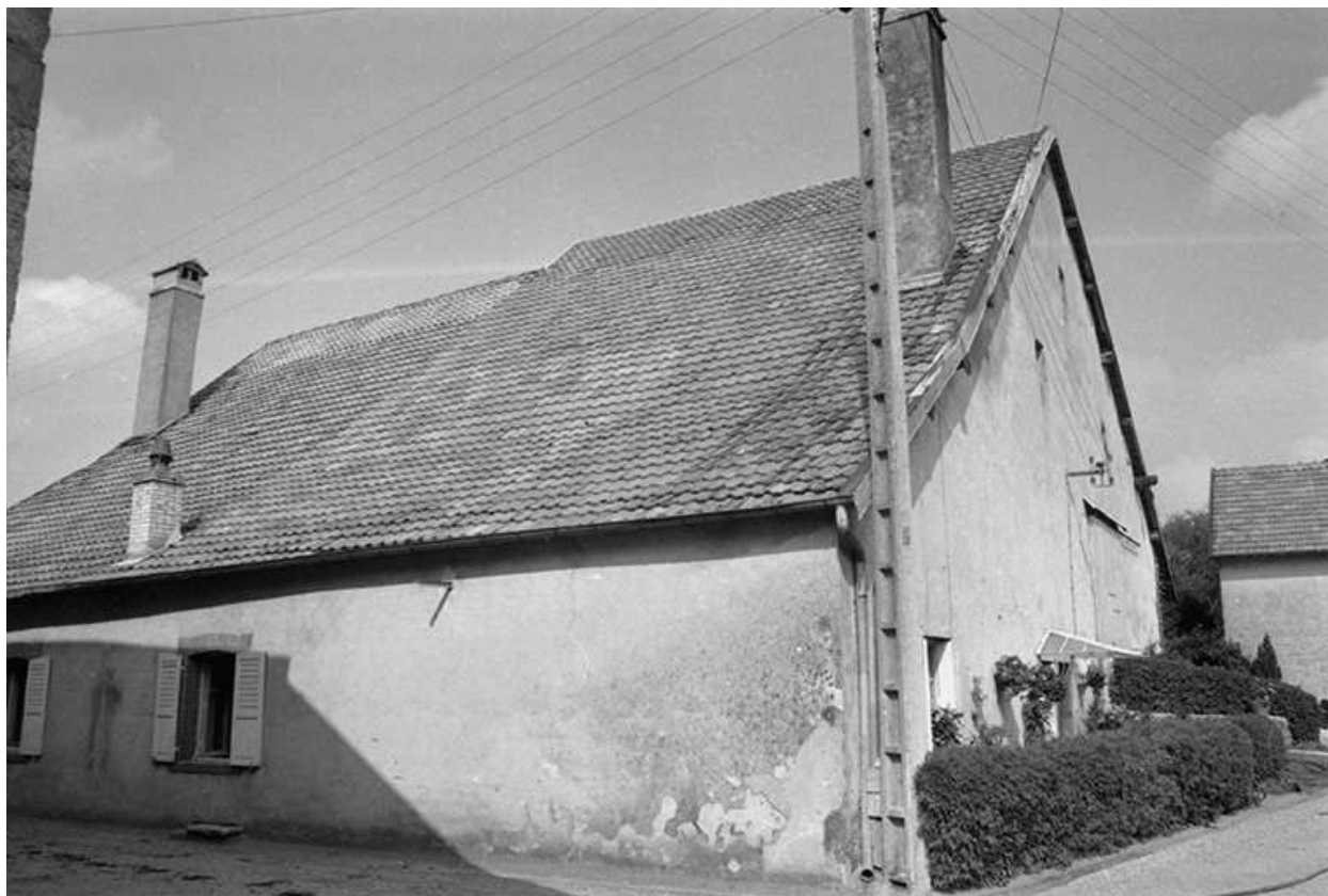
Ferme située rue de Tarcenay.
