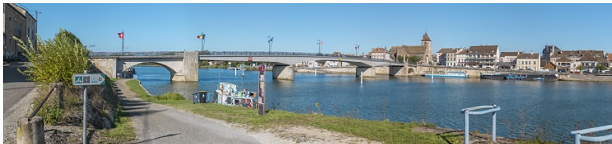
Vue d'ensemble depuis Losne, rive gauche.
