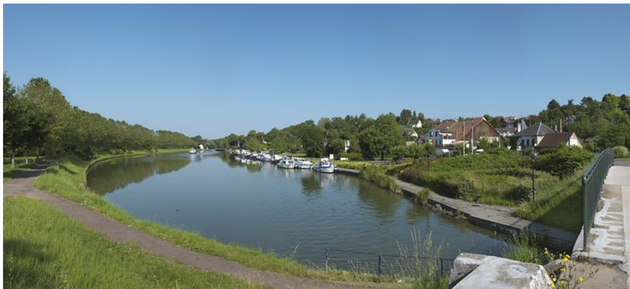
Vue générale du port de Saint-Thibault.
