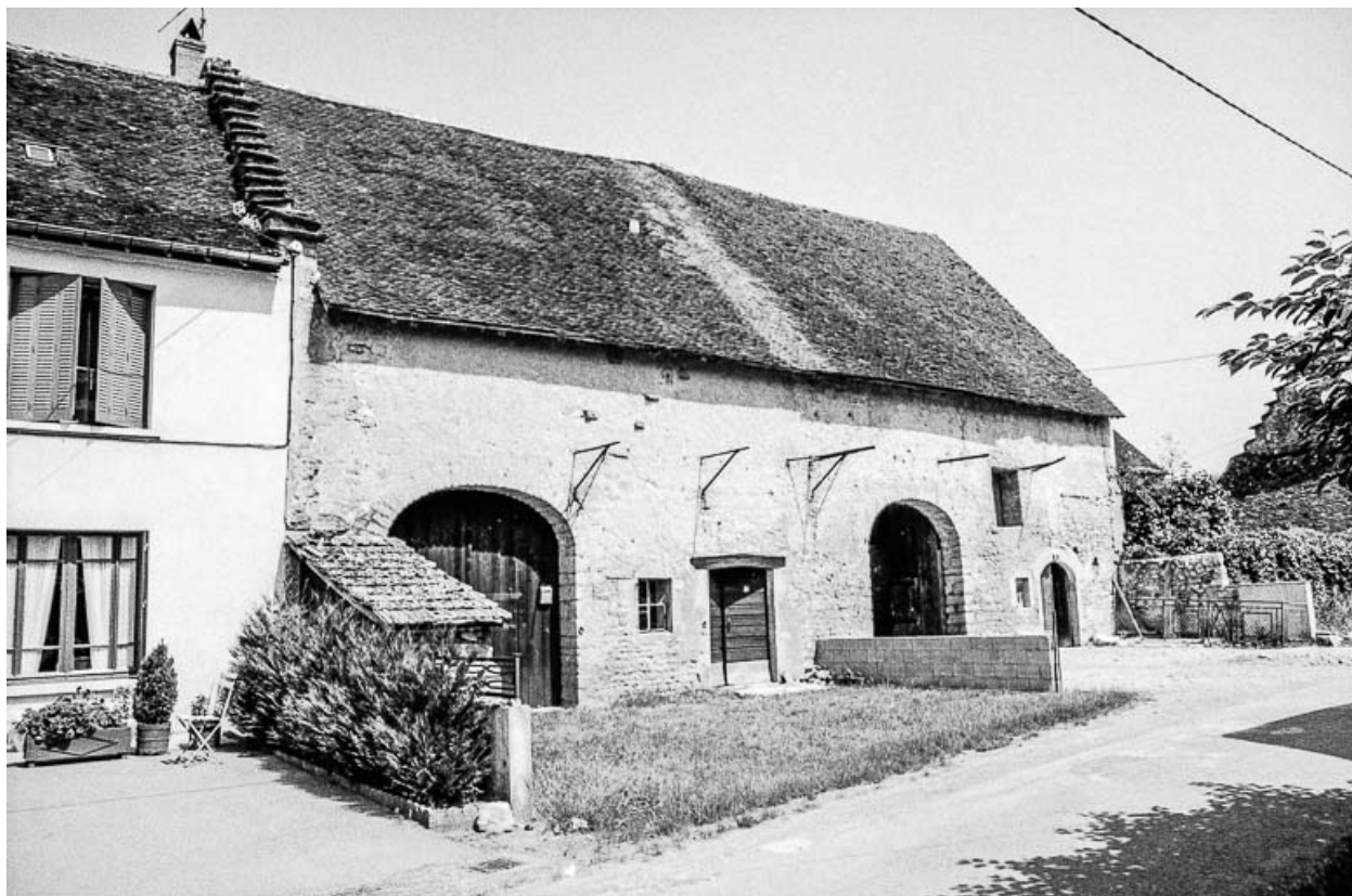
Ferme située rue Saint-Christophe : vue de trois-quarts gauche.
