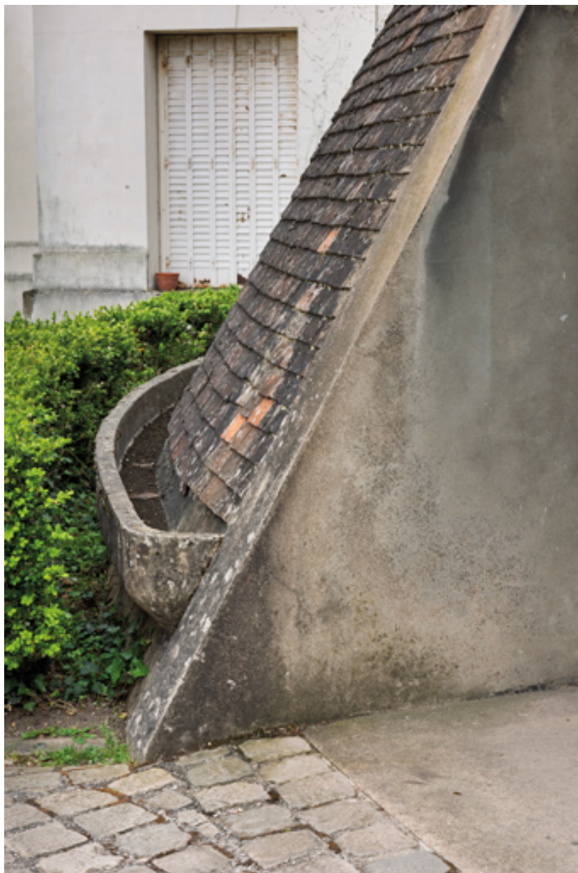
Jardinière à la base de la toiture.
