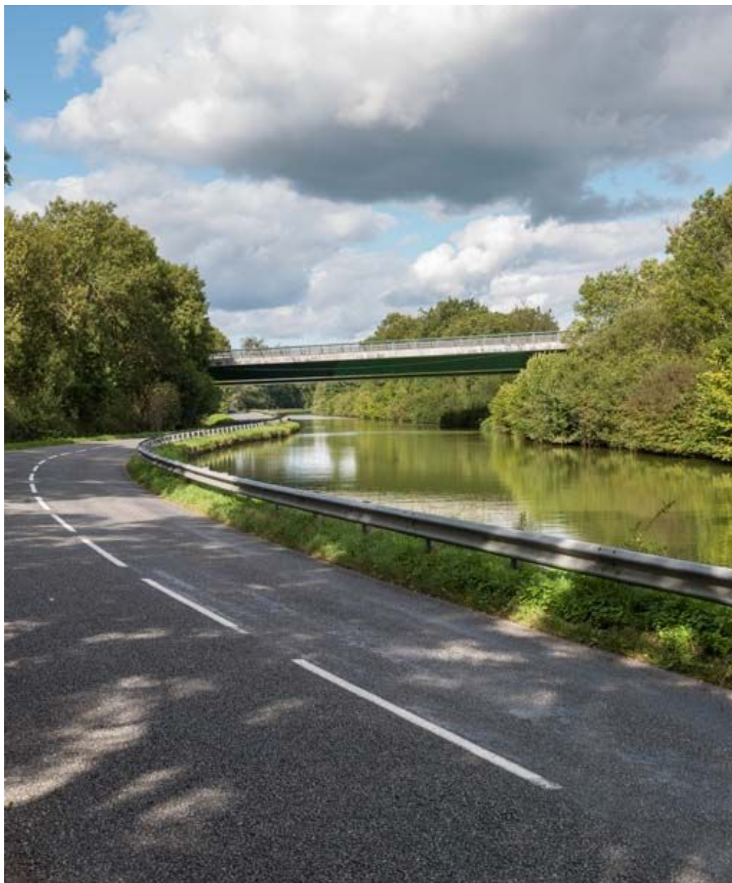
Vue d'ensemble du pont.
