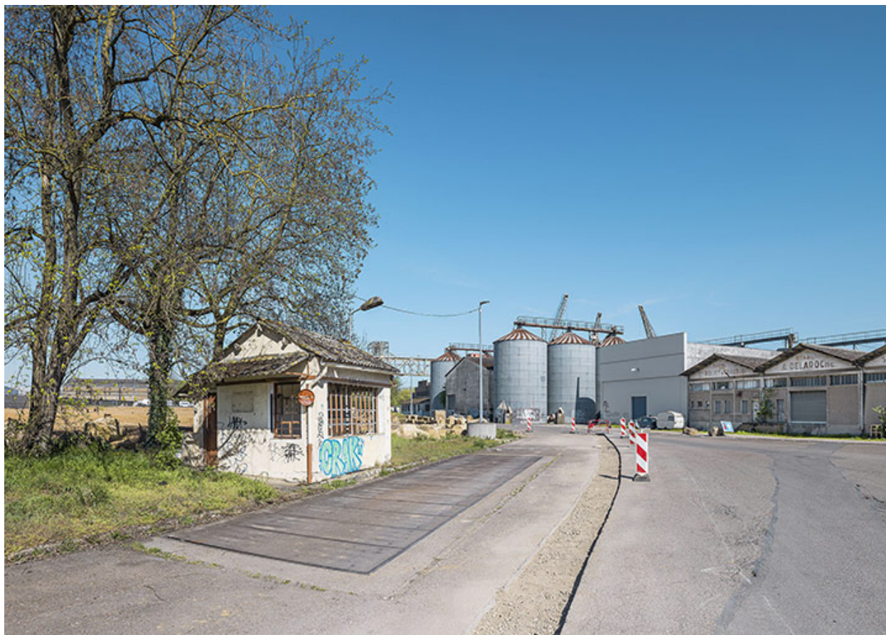
Pont-bascule (routier) et son poste de commande (désaffecté).
