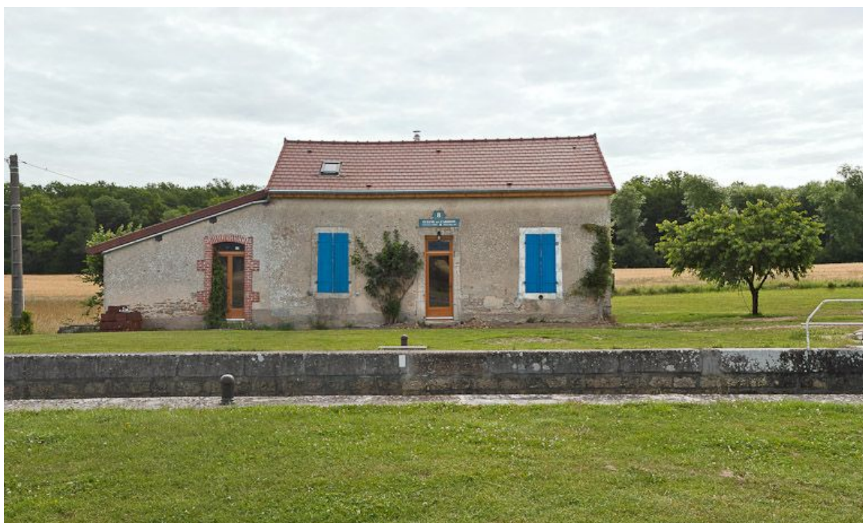
Vue de face de la maison éclusière.
