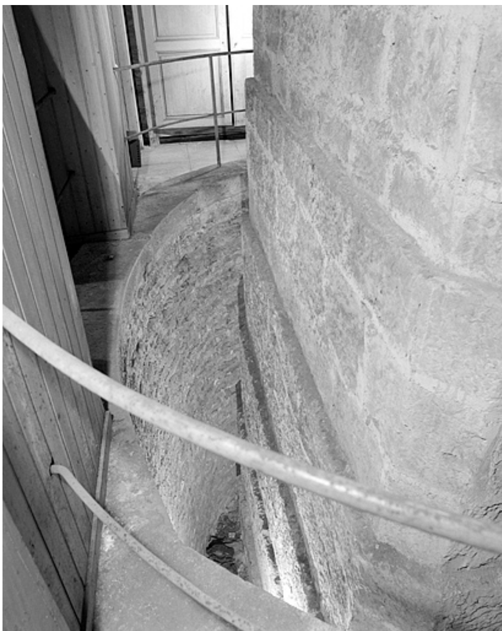
Sous-sol : puits du pilier de la lunette méridienne.
