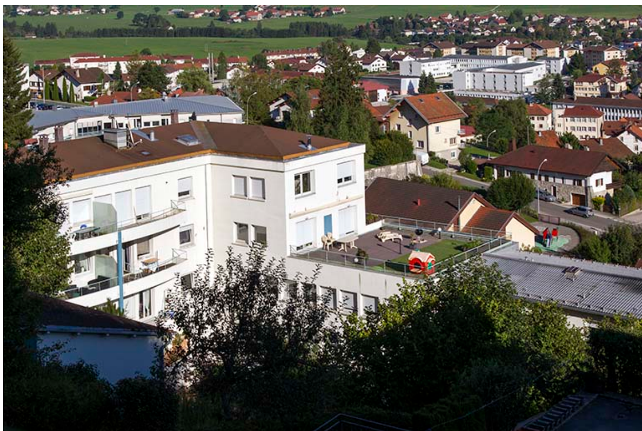
Façades postérieure et latérale gauche (vue plongeante).
