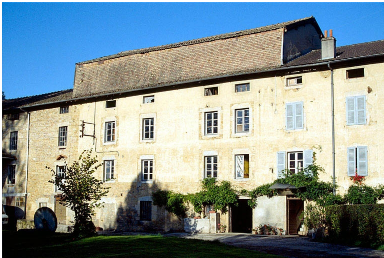
Partie centrale de la minoterie.
