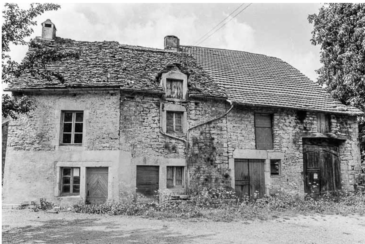
Ferme cadastrée 1951 E1 76 : façade antérieure.
