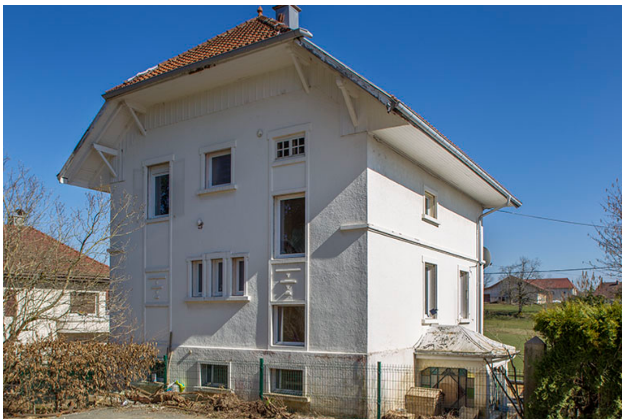
Façades postérieure et latérale gauche.
