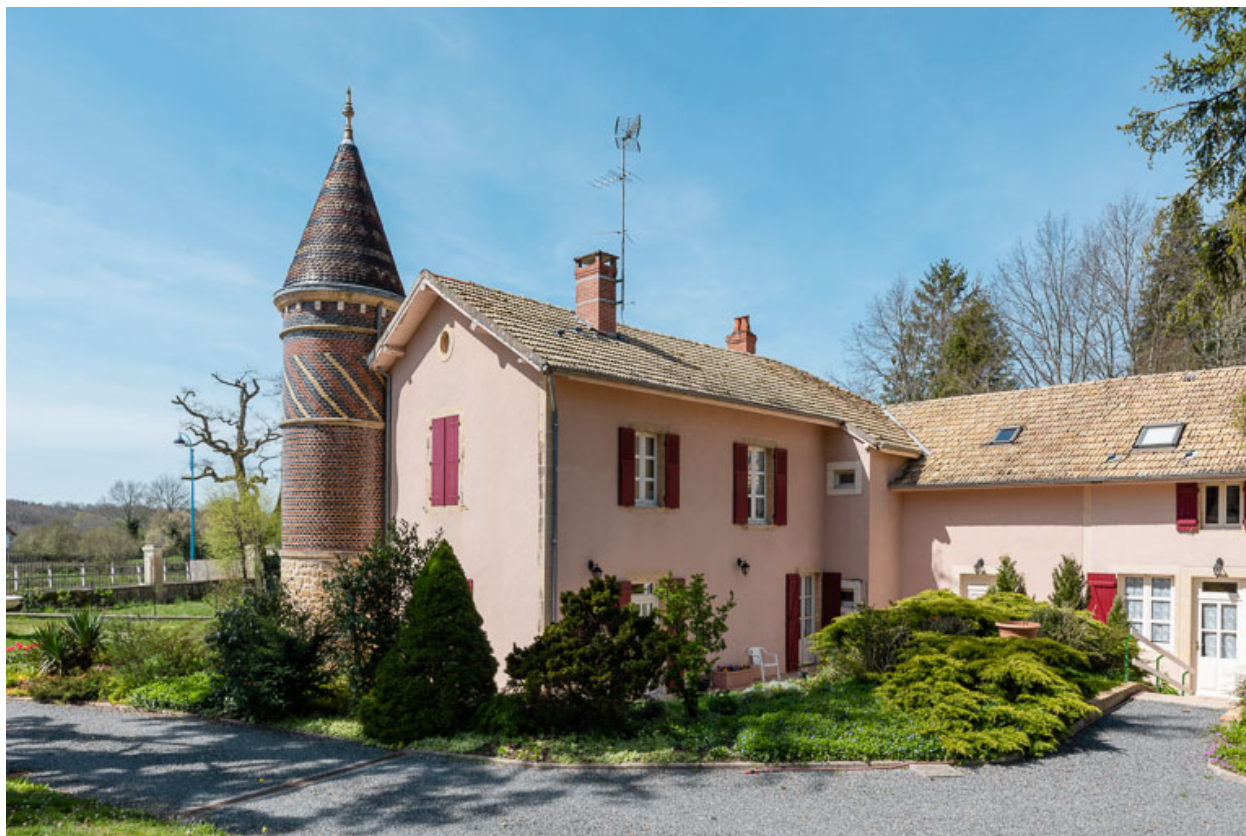
Façade nord-est, vue depuis l'est.
