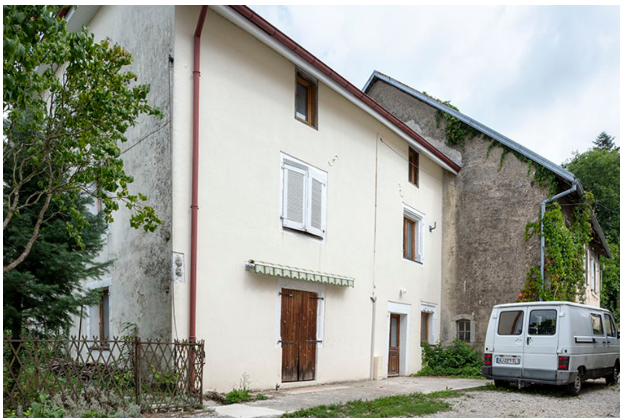
Bâtiment de 1723 : façade antérieure, de trois quarts.
