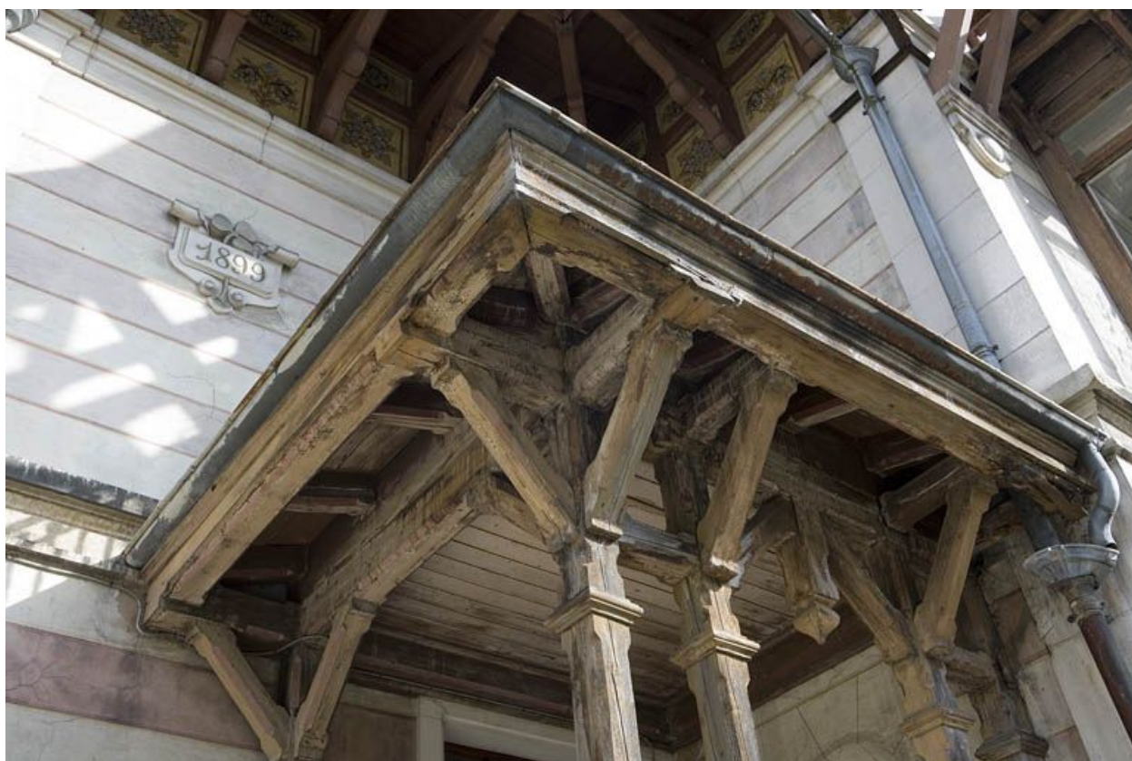
Elévation antérieure : charpente du porche.
