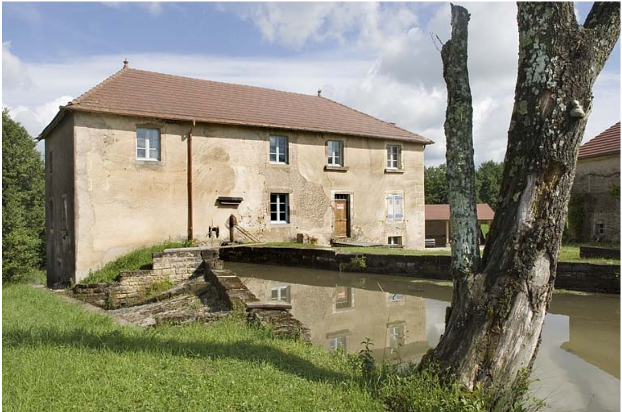
Façade sud du moulin.
