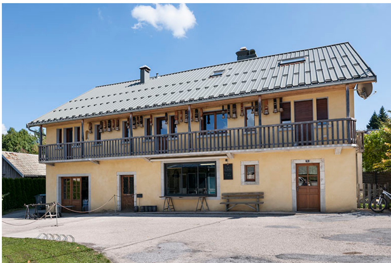
Façade ouest de l'atelier de fabrication.
