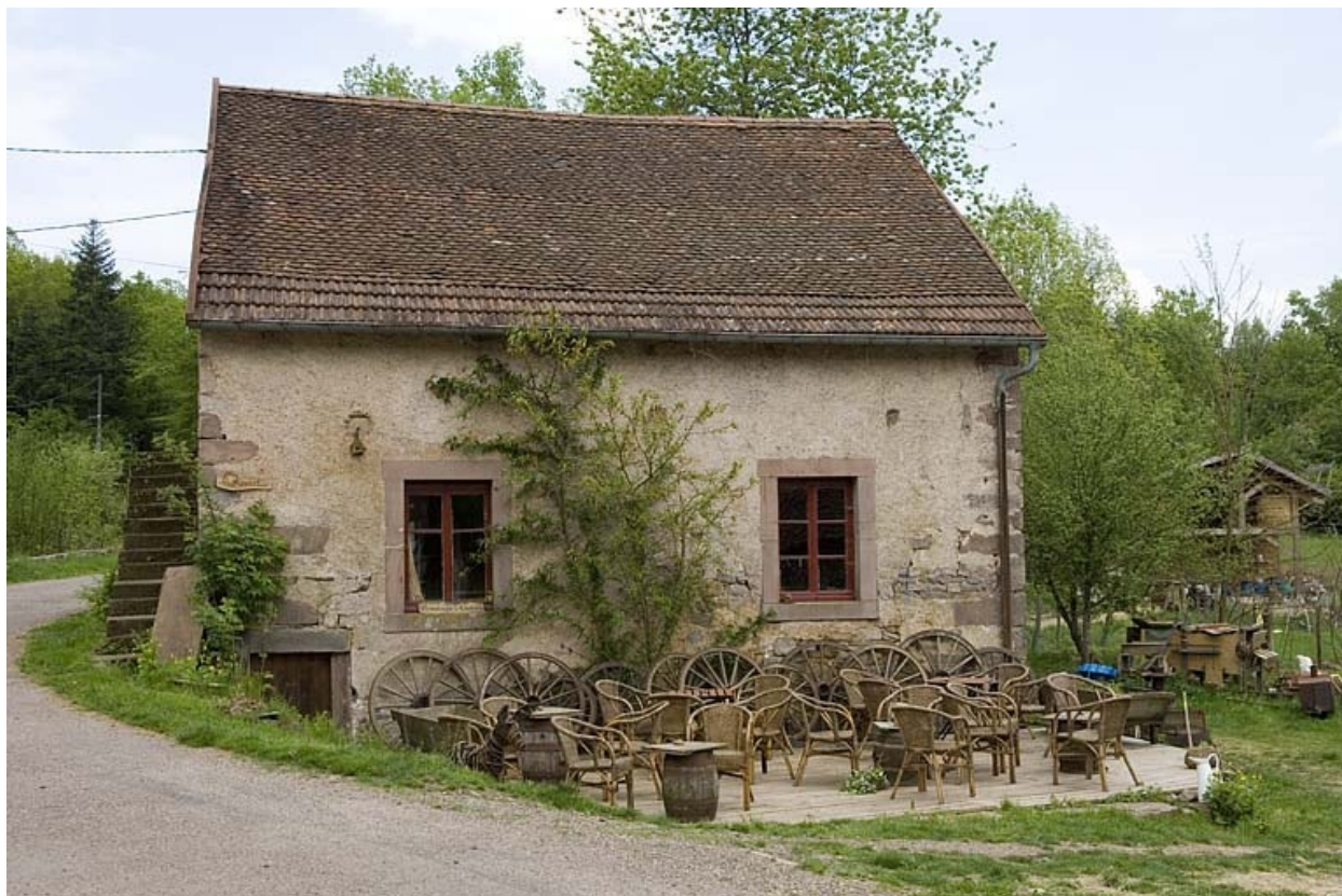
La façade ouest du moulin à farine.
