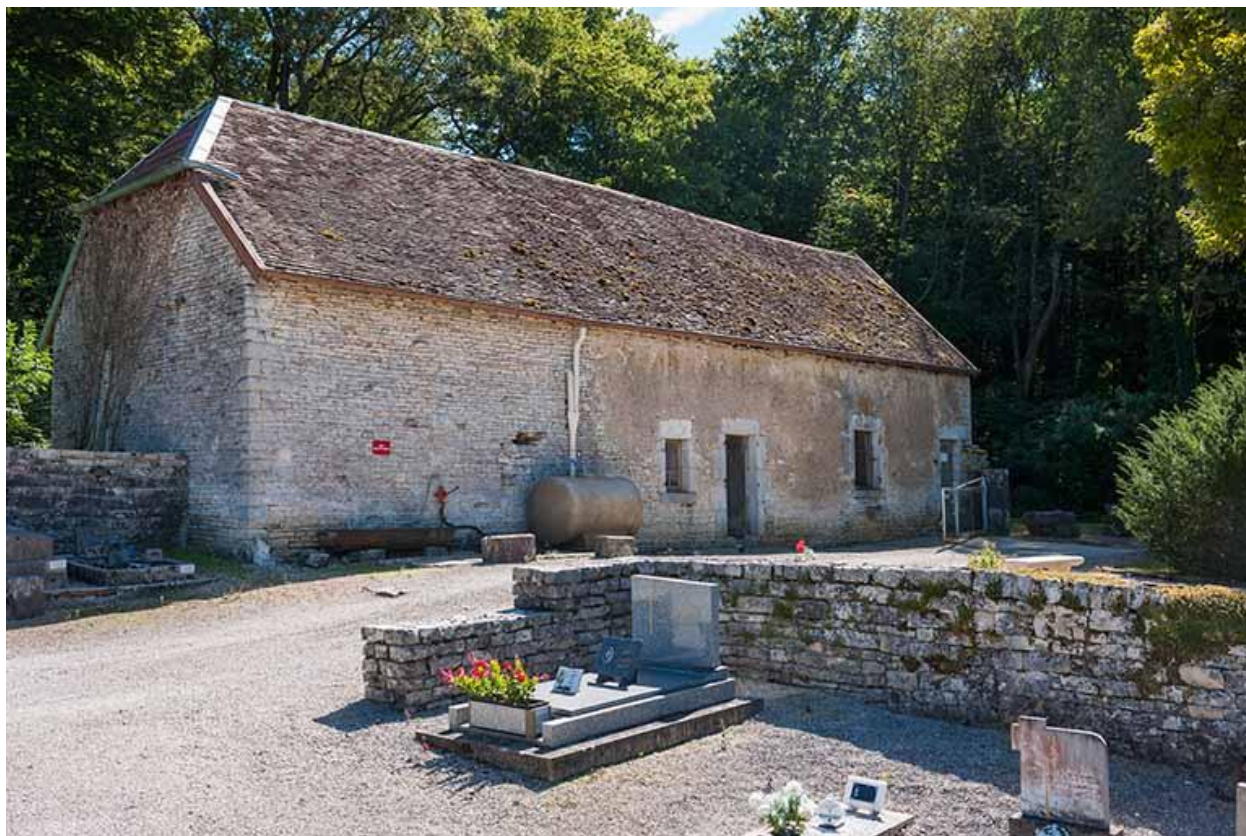
Ancienne ferme située au sud-ouest du cimetière
