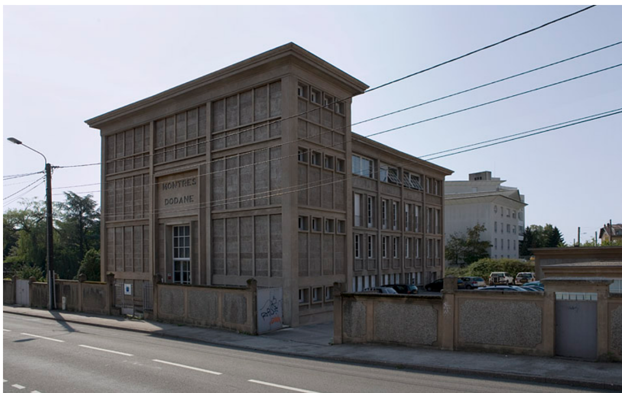
Façades antérieure et latérale droite.
