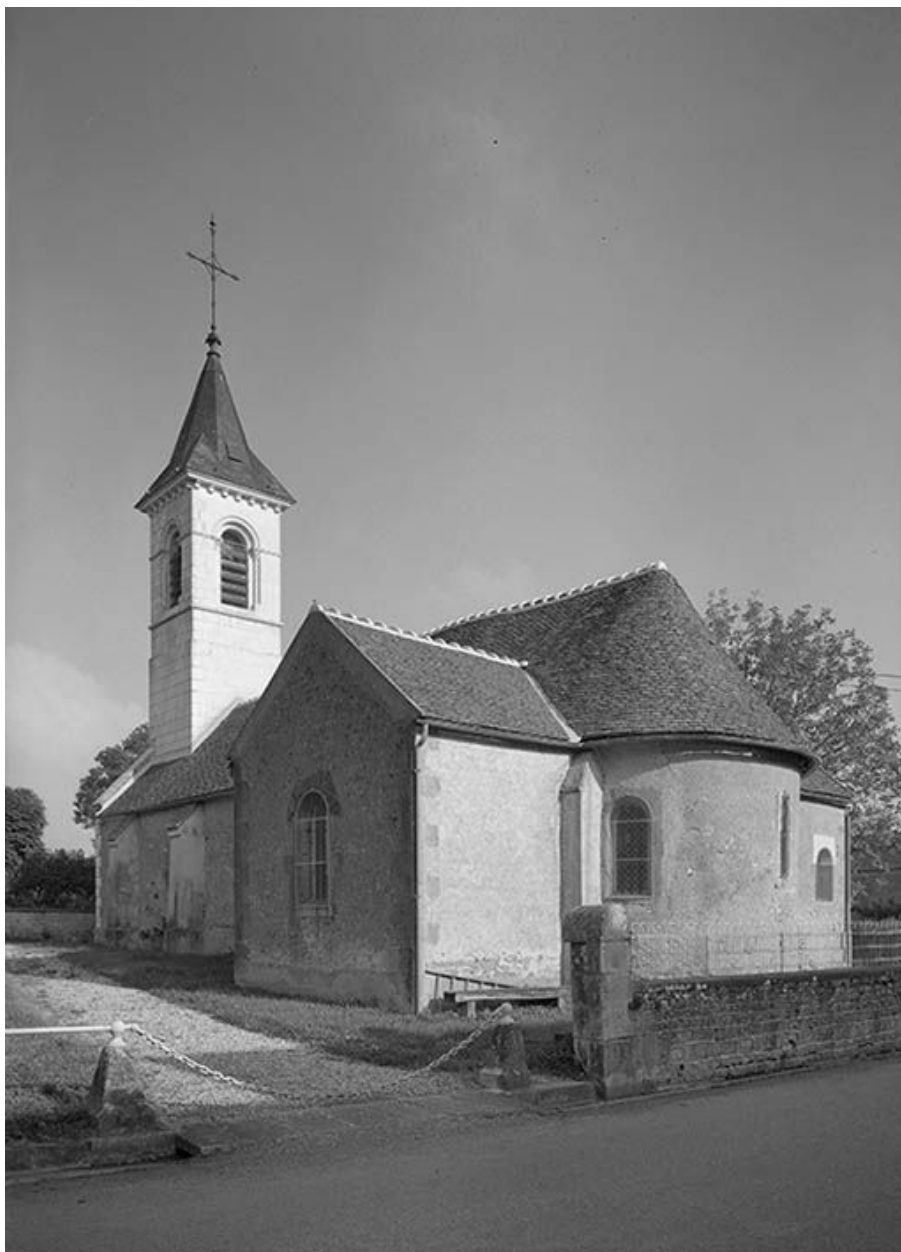
Elévation droite et abside
