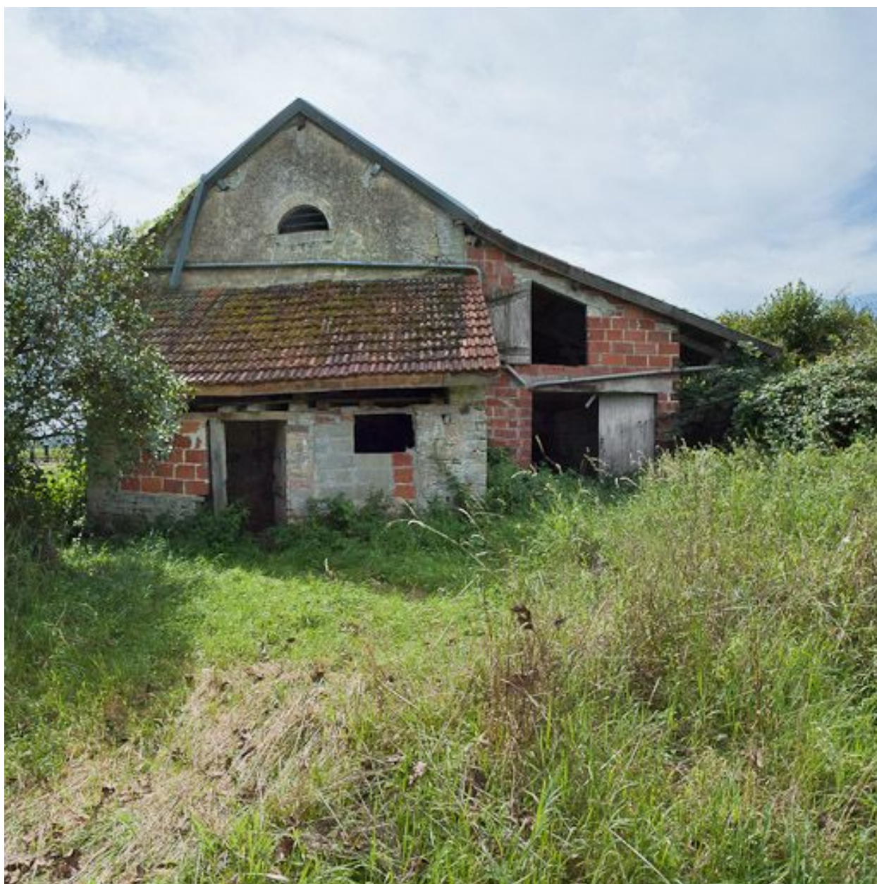
Vue latérale de la maison éclusière.
