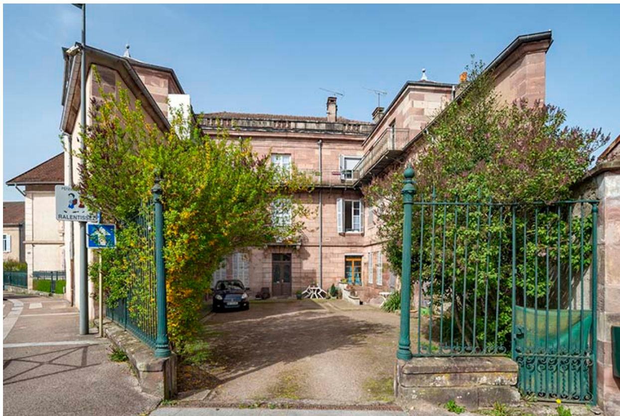
Façade sur la cour.
