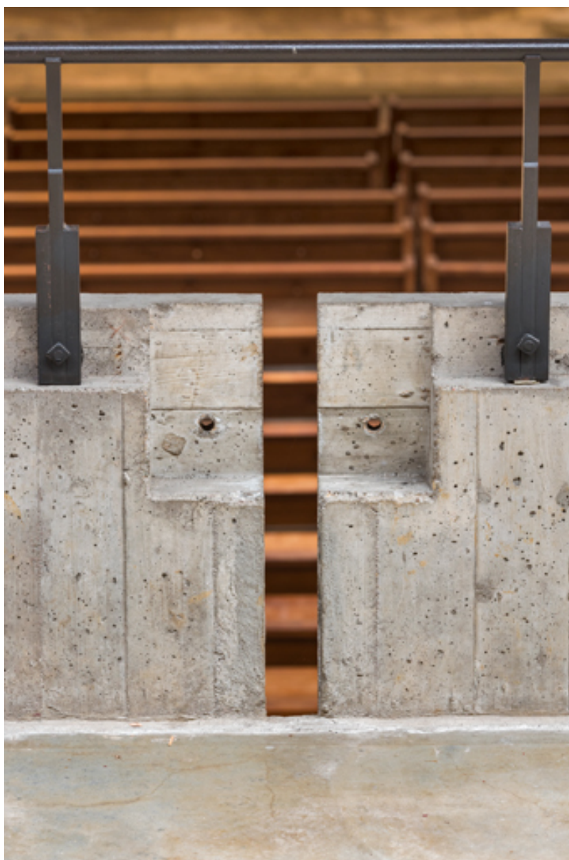
Garde-corps de la tribune sud. Détail.
