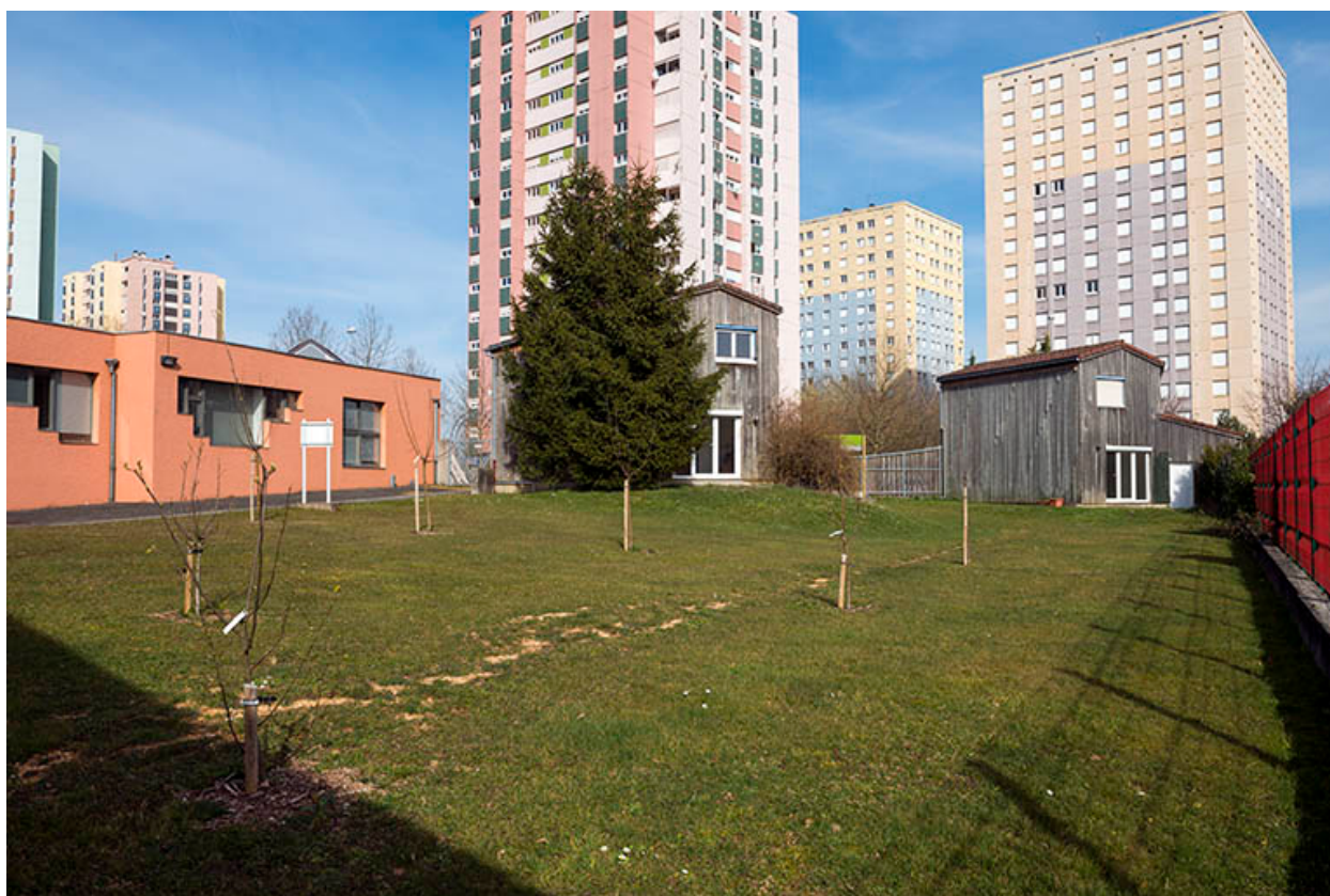
Façades postérieures des logements de fonction orientaux.
