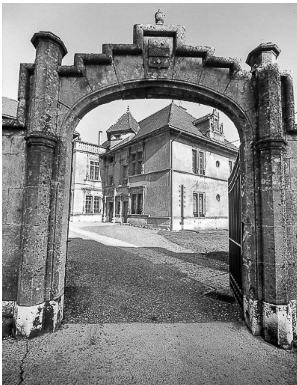
Vue d'ensemble avec le portail.
