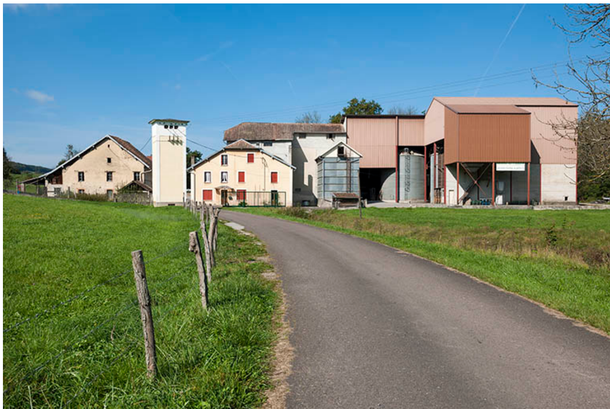
Vue depuis la route d'accès.
