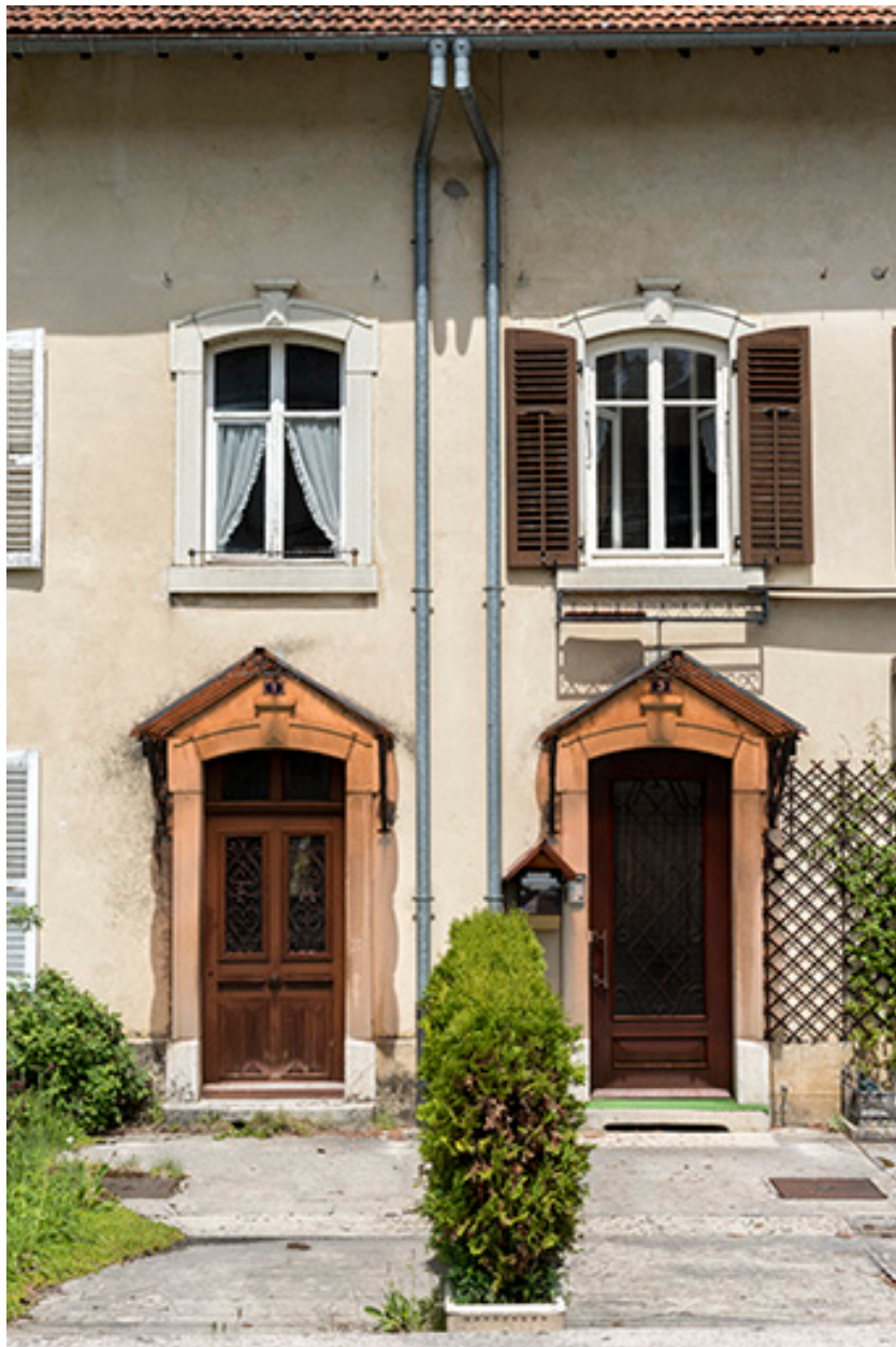
Maison, façade antérieure : travées centrales.
