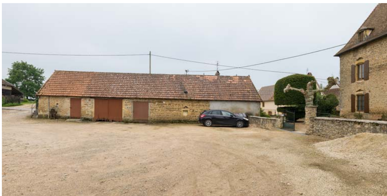
Bâtiment agricole : écurie, remise et bûcher.
