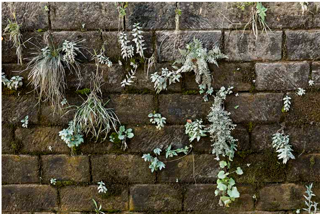
Détail sur la maçonnerie d'une écluse.
